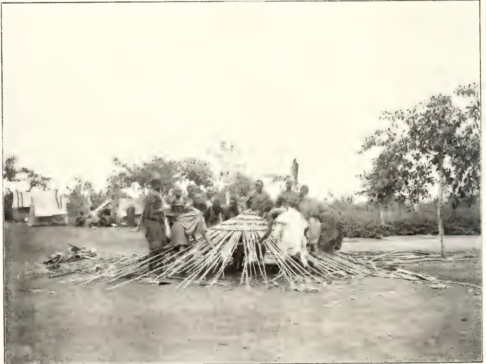
Abb. 355. Bau einer Waganda-Hütte (erstes Stadium).
